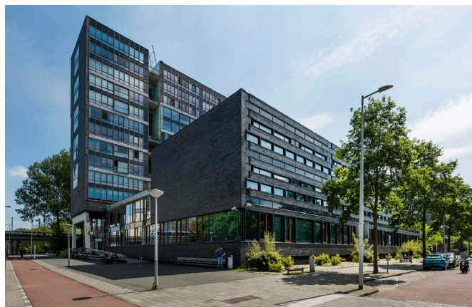
Bürogebäude „Pieter Calandlaan“, Amsterdam, Niederlande
